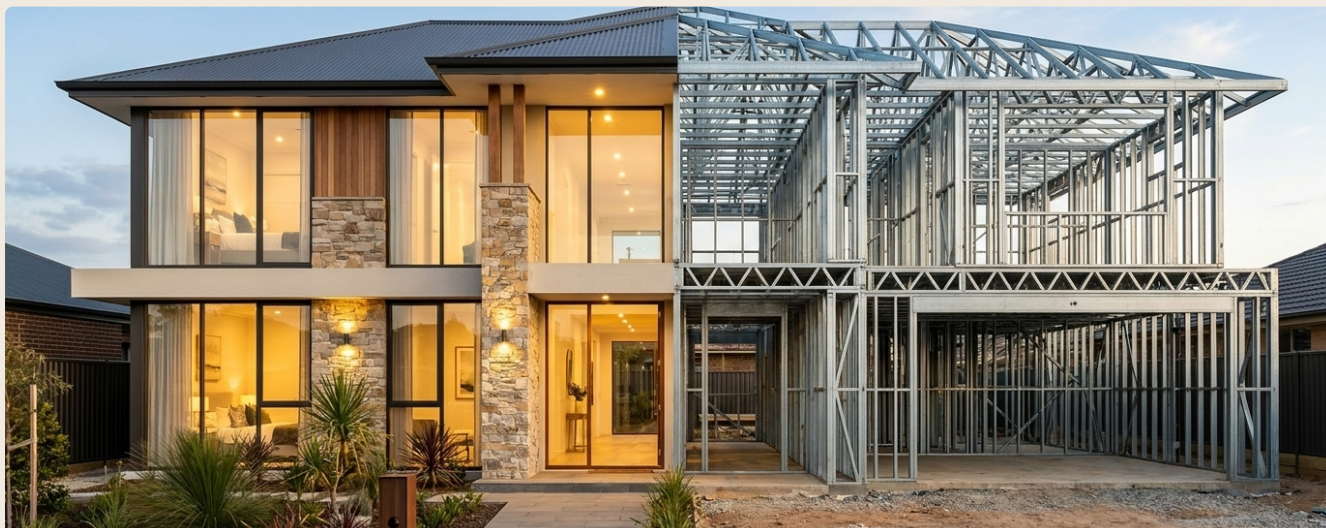
Da estrutura ao acabamento de alto padrão — a mesma casa, do esqueleto em steel frame à entrega.
